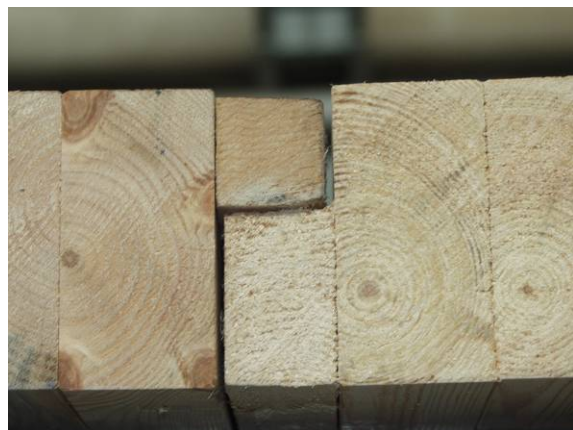
Abbildung 6-11 Stoßausbildung zwischen den beiden Deckenelementen der Brettstapeldecke
