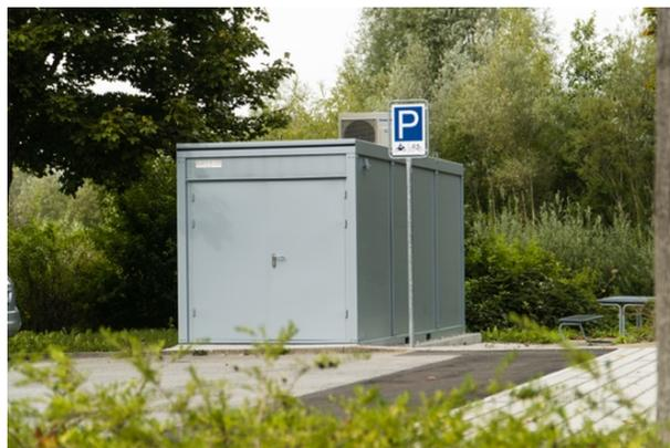
Klimatisierter Container mit Batterie, Leistungselektronik und Kommunikationstechnik
