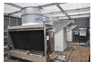
Abb. 2: Jaeggi Hybridrückkühler im Z3
